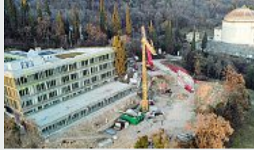
Il cantiere La nuova clinica accanto al Tempio del Canova
